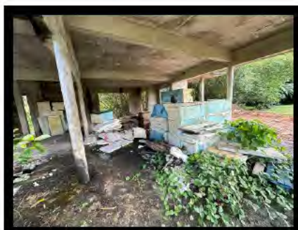
Matériaux d'isolation stockés et dégradés
