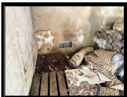
Matériaux d'isolation stockés et dégradés
